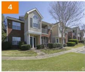
4 Central Park 2400 Central Pkwy. Montgomery, AL 36106
